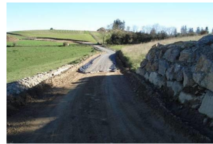
Illustration 23 : Mise en place du gravier
