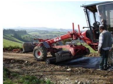
Illustration 22 : Pose du géotextile
